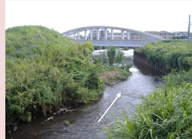
改修前の状況(寺尾橋下流)
