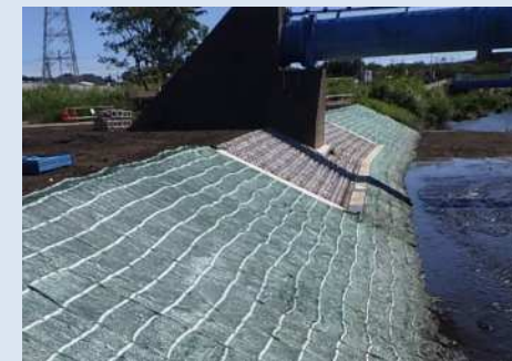
護岸ブロック+覆土構造
