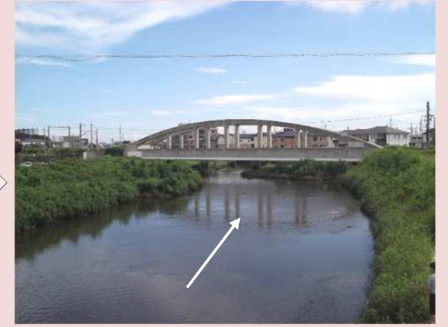
改修後の状況(寺尾橋下流)
