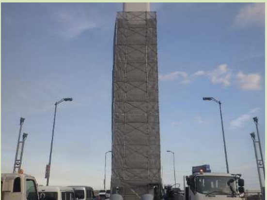
施工状況(P3主塔)
