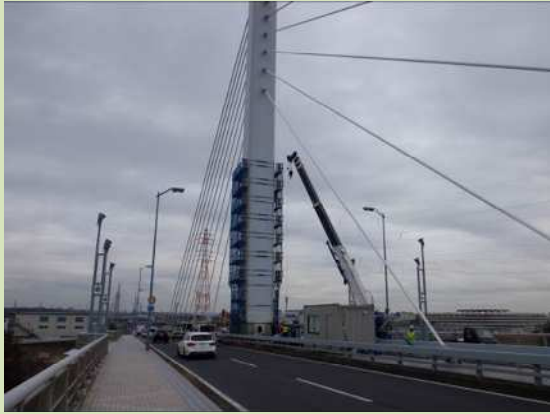
施工状況(P2主塔)
