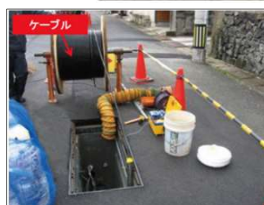
入線工事(国土交通省HPより)
