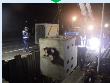
③-4 ケーブルを分岐・接続する特殊部の設置
