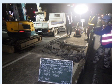
③-2 掘削状況
