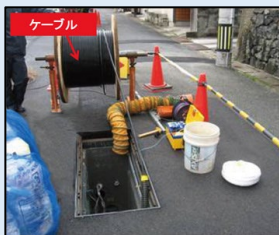
入線工事（国土交通省HPより）
