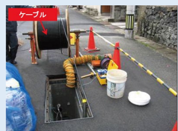
⑤ ケーブルを管路に入線 (国土交通省HPより)
