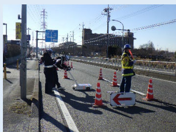
②-1 地下埋設物の3次元化調査
