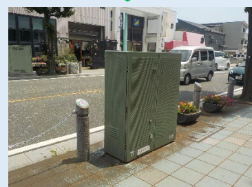
⑥ 各種ケーブル類の接続を行う 地上機器の設置 (県道 40 号 (横浜厚木) の事例)
