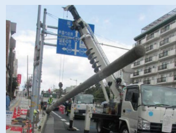
⑦ 電線・電柱の撤去 (国土交通省HPより)
