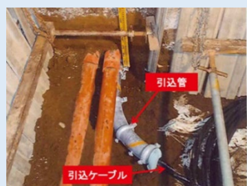
④ ケーブルの敷設と引込部の施工 (国土交通省HPより)
