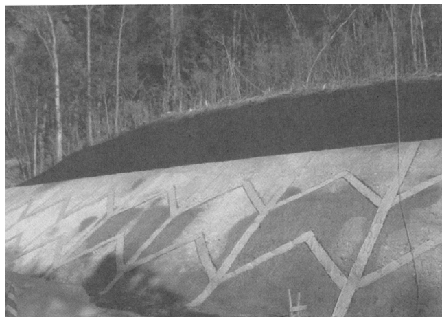
【図Ⅲ. 6-20 切土のり面に設置する暗渠排水工の例】
