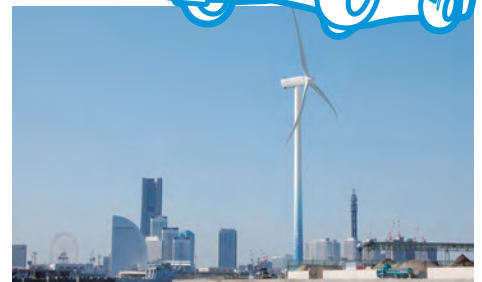
横浜市風力発電所「ハマウイング」
