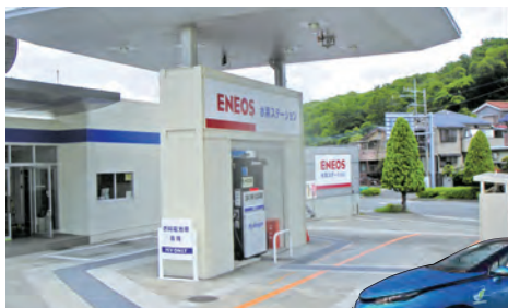
横浜旭水素ステーション
