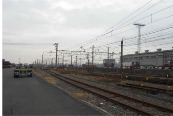
写真 - 川崎貨物駅 (品川方面を望む)
