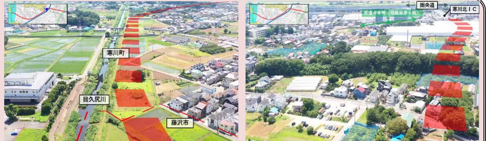
道路予定地の現在の状況
