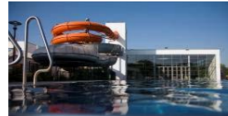
公共温水 プール
