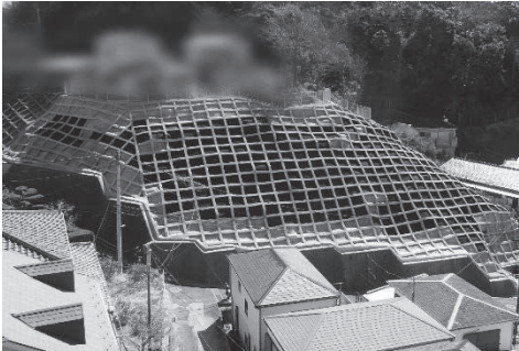
急傾斜地崩壊防止施設整備
