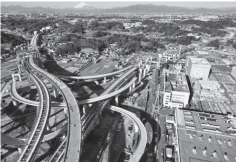
横浜湘南道路整備
