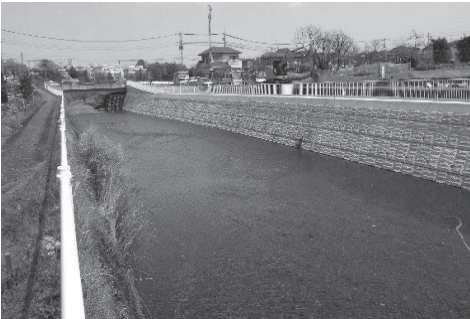
引地川護岸整備
