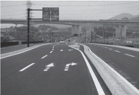
県道 603 号(上粕屋厚木)整備
