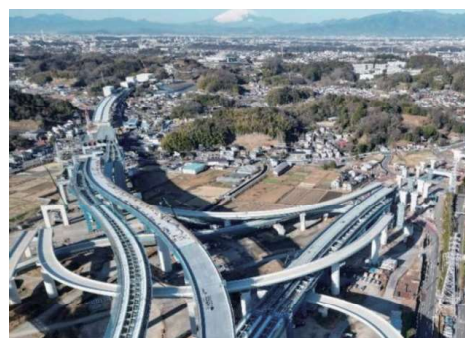
活用例 ▶ 横浜湘南道路整備 <写真提供：横浜国道事務所>
