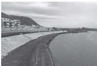
金目川堤防整備
