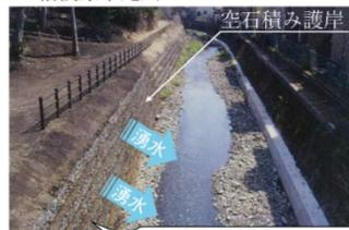
左岸側の護岸を空積みにするにより段丘の断面面からの湧水量を増やして、水質の改善を行う。
