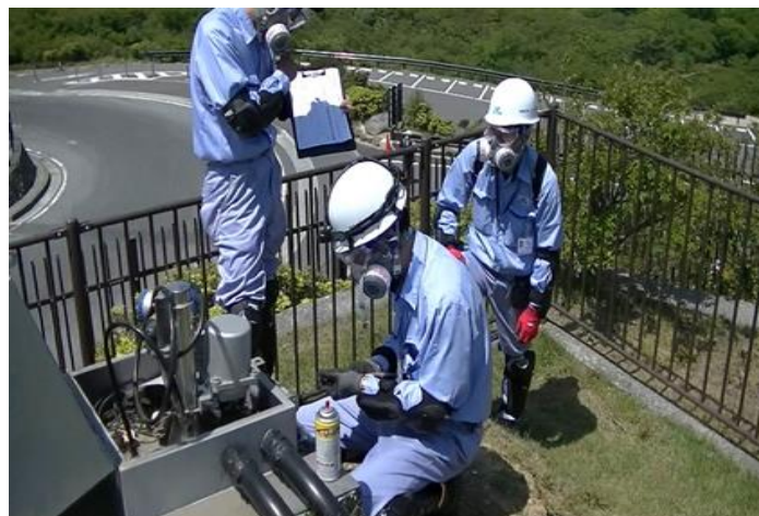
大涌谷火山活動対応（大涌谷配水池の点検）
