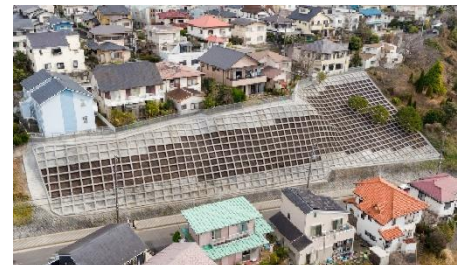
急傾斜地崩壊防止施設 池子3丁目B地区（逗子市）
