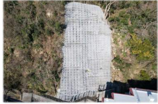
住宅に近接した県有緑地の防災工事の例 (鎌倉市坂ノ下)
