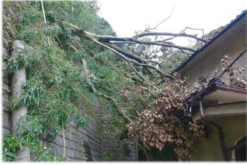
住宅地に近接した緑地の倒木による被害 (鎌倉市内)
