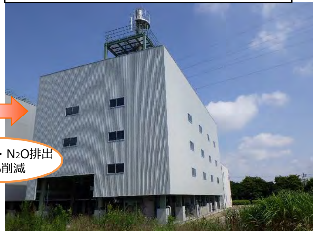
右岸処理場：北系3号焼却炉 (省エネ・低排出型に改築)
