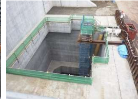
発進立坑（R2.9完成）
