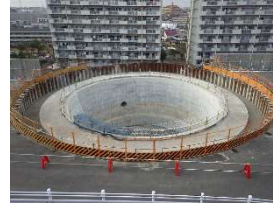
中間立坑（H29.3完成）
