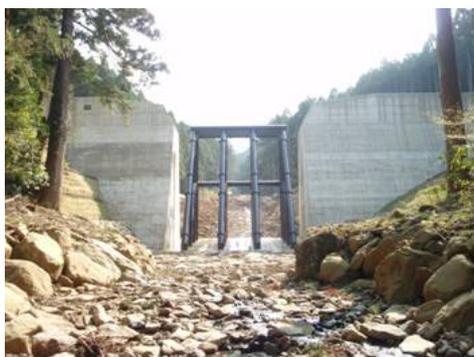
写真7 透過型砂防堰堤（酒匂川水系 大雄川）
