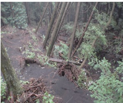
崩壊した林地
