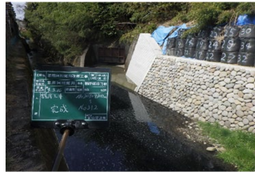
自然石を使用した護岸
