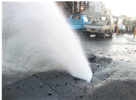
(道路面からの漏水噴出状況)
