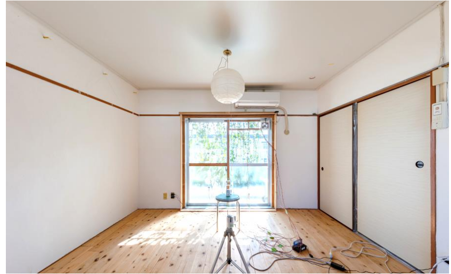
最上階の天井断熱+膜天井 簡易的な2重サッシ化
