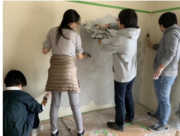
漆喰材による壁塗り
