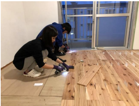
フローリングへの改修
