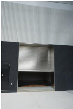
サイロ室搬 入口
