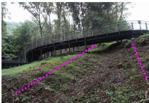
遺構を壊さず園路を整備
