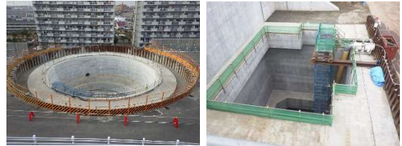
中間立坑（H29.3完成） 発進立坑（R2.9完成）
