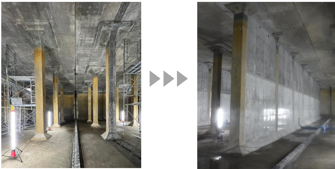
【図 11】耐震補強工事（耐震壁の設置）
