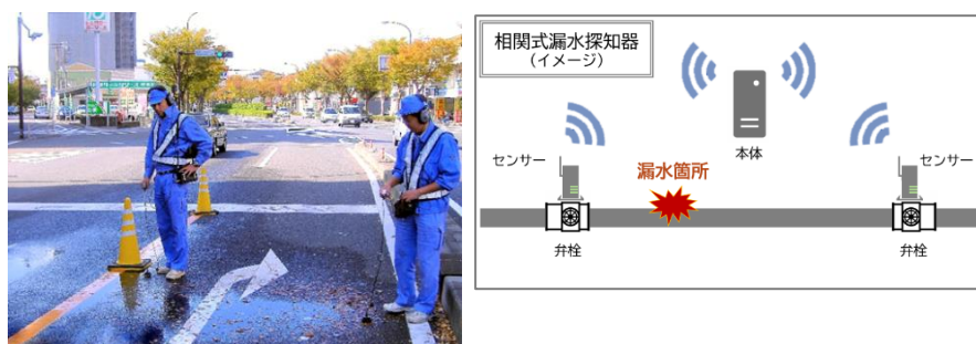
【図10】 漏水調査の様子
