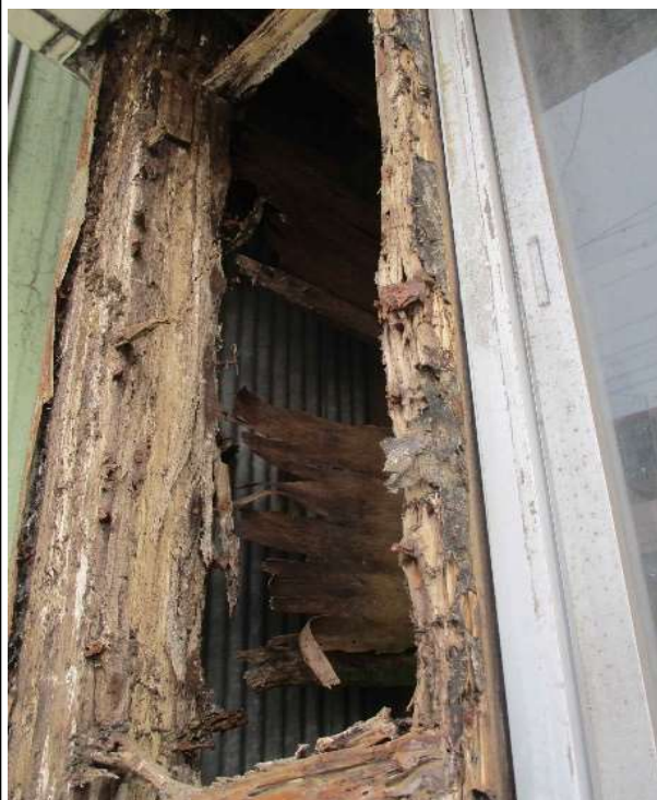
柱・梁の腐朽
