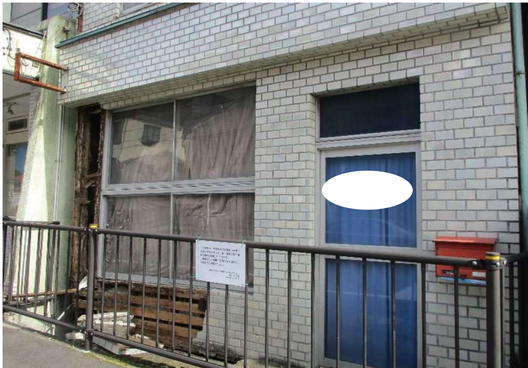
柱・梁の腐朽
