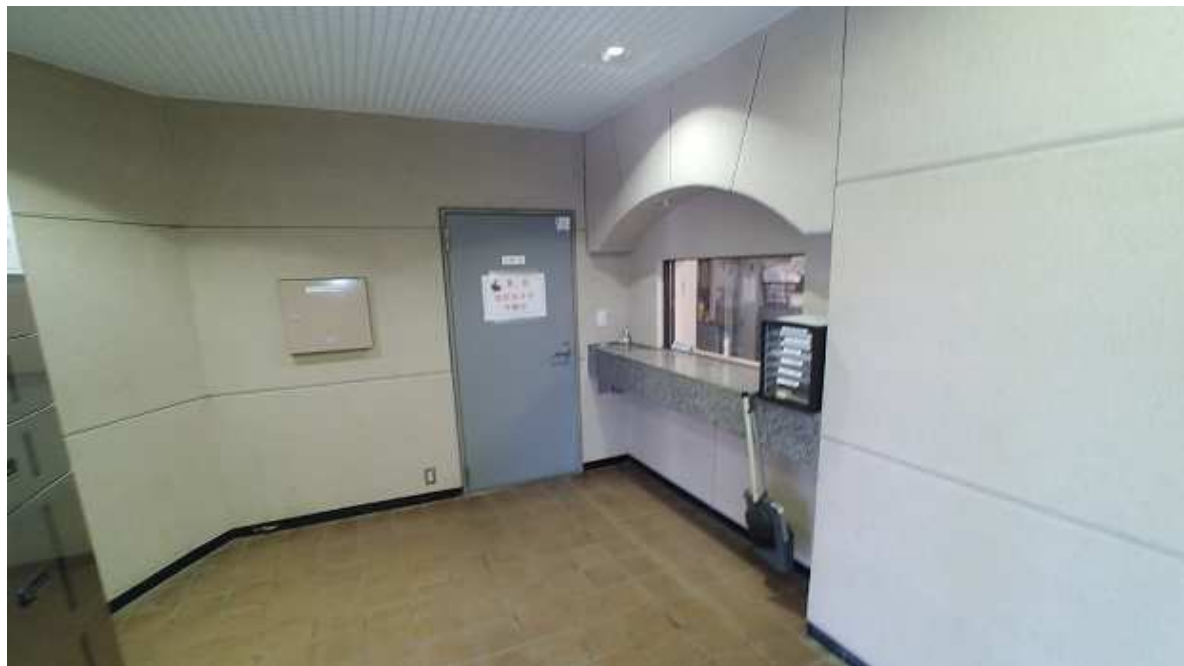
(1階管理人室 ⑤より令和7年5月撮影)
