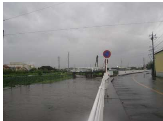
水路拡幅による周辺被害防止
