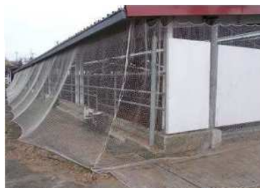
防鳥ネットの補修
