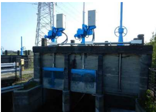
水門の遠隔電動操作化
