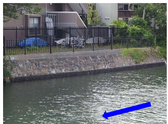
新設護岸の整備状況
