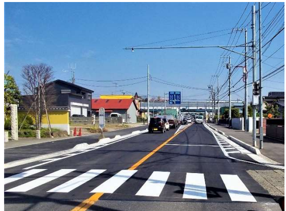
① 整備済み区間の状況
