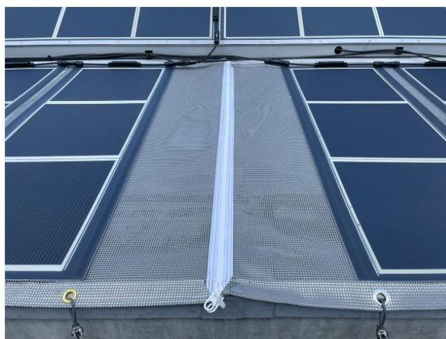
図表 14 ファスナー取り外し式工法の設置状況
