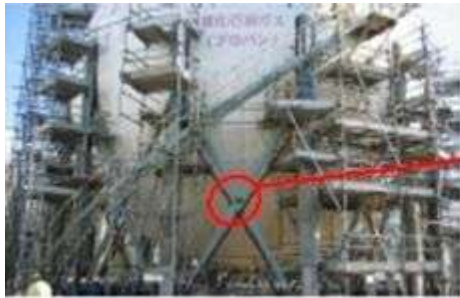
東日本大震災で、他県で破断した高圧ガスの脚柱
