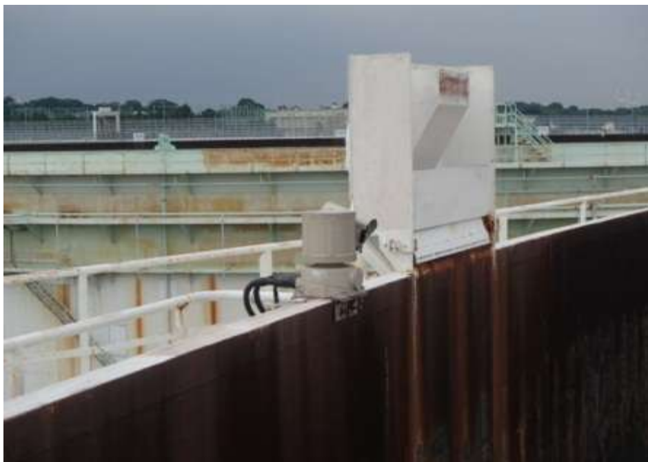
危険物タンクの監視モニター と監視状況
