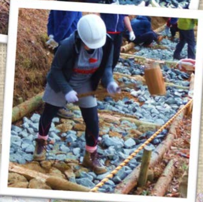
↑丸太で作った枠を、 カケヤ（ハンマー）で 杭を打って固定する→
