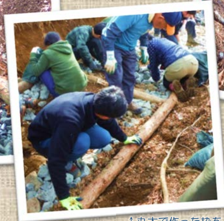
↑丸太で作った枠を、 カケヤ（ハンマー）で 杭を打って固定する→
