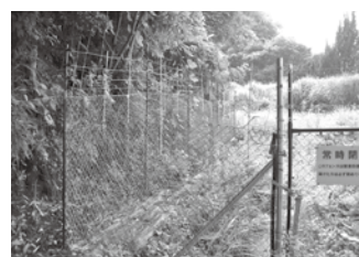
防護柵設置状況
