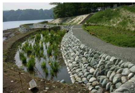
三井地区植物浄化施設
