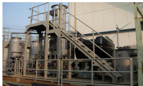
地下水浄化設備(秦野市)
