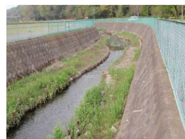
生態系に配慮した河川の整備(厚木市)
