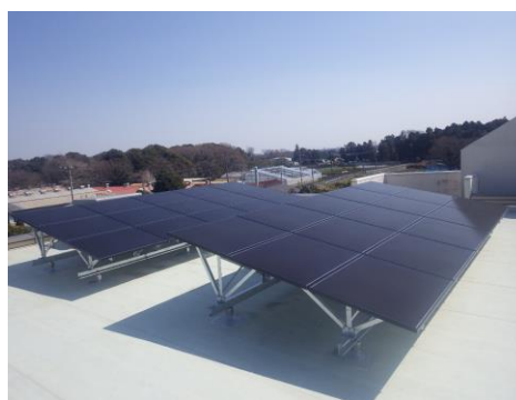
かながわ農業アカデミーに設置した太陽光パネル
