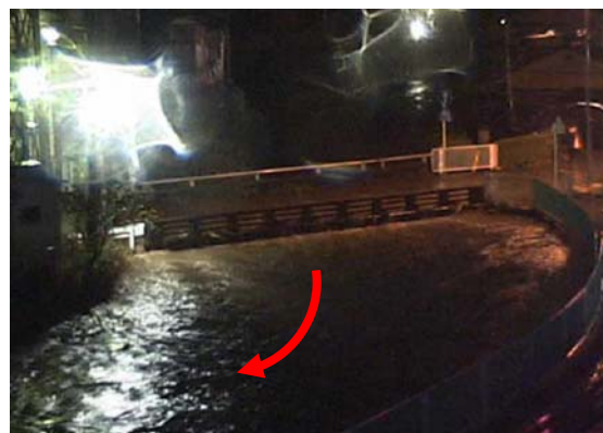
平成25年の浸水状況（内輪橋）
