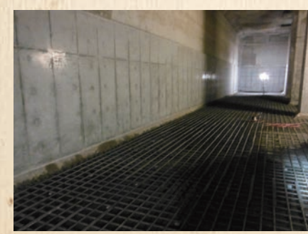
配水池内部をコンクリートや鉄筋で補強している様子
