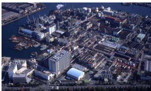
川崎工場全景
