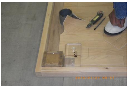
CFシートの施工
