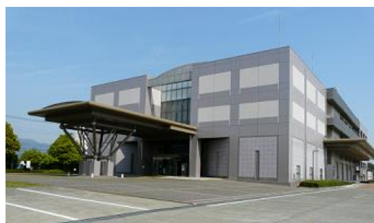
ESCO事業を導入している総合防災センター・消防学校
