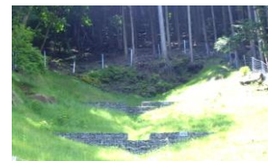
自然石を使用した土壤保全対策
