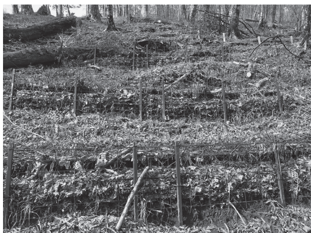
写真3 金網筋工
