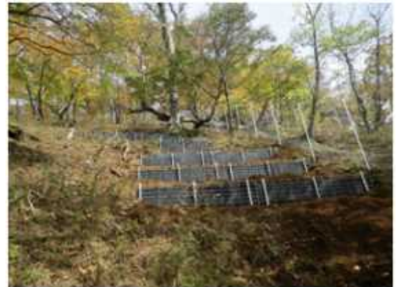
土壌保全工実施箇所
