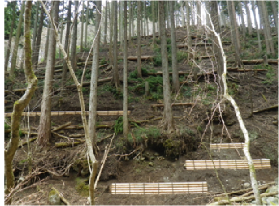
溪畔林整備施工地（笹子沢）
