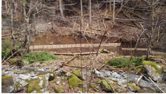
溪畔林整備施工地（大滝沢）
