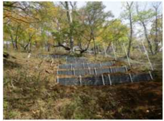
土壌保全工実施箇所
