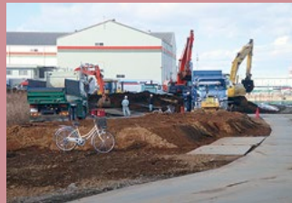
造成工事の様子
