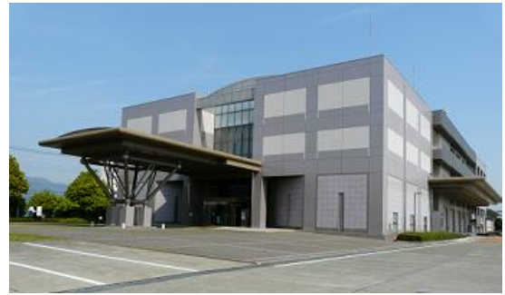
ESCO事業を導入している総合防災センター・消防学校
