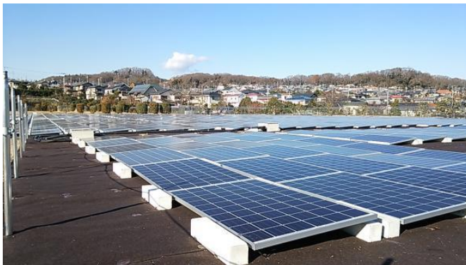
谷ヶ原配水池上部に設置した太陽光パネル
