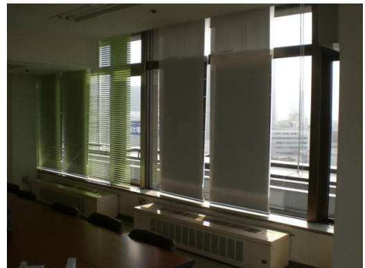
かながわ県民センターに設置したロールスクリーナー体型薄膜太陽電池
