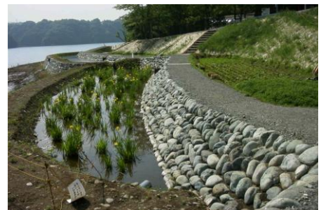
三井地区植物浄化施設
