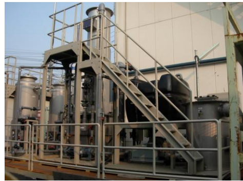
地下水浄化設備(秦野市)
